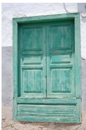
16. AR-386 VENTANA DOBLE CON TABLERO INFERIOR FIJO
